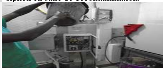
Photo 3. Coffret électrique exposé à l'eau.
