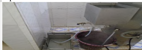
Photo 5. Manipulation dangereuse des effluents chauds.
