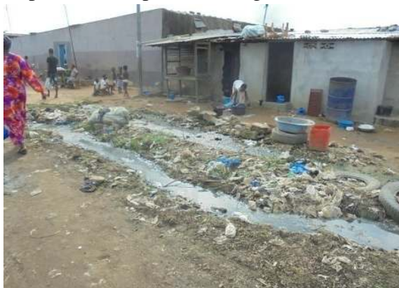
Photo 3 : Eaux usées de toilettes ruisselant dans la rue au sous quartier Forêt sacrée/ Cliché : Aké-Awomon, Avril 2017
