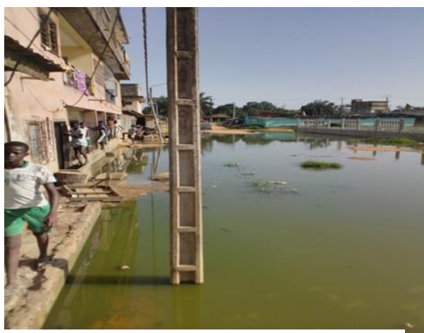
Photo 6 : Stagnation d'eaux dans une rue au sous-quartier Forêt-Sacrée / Cliché : Tuo, Avril 2017
