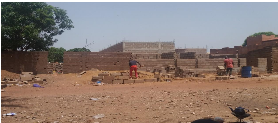
Photo2: Construction d'un migrant à Kalabancoro Source : Adama KONE, 2020
