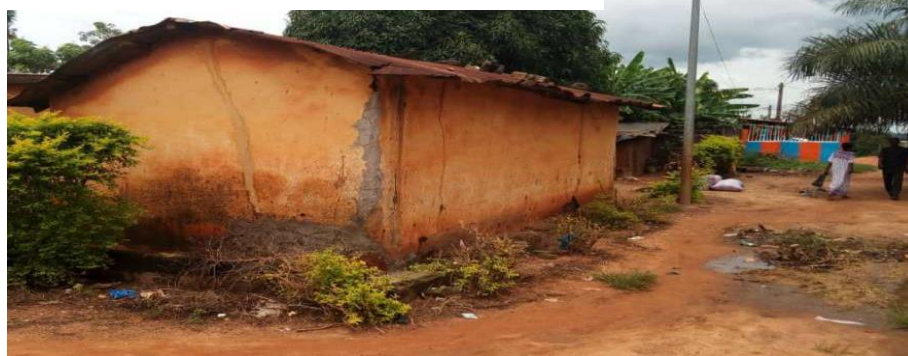
Photo3 : une maison basse simple à Dougako, cliché DIHOUEGBEU, 2021
