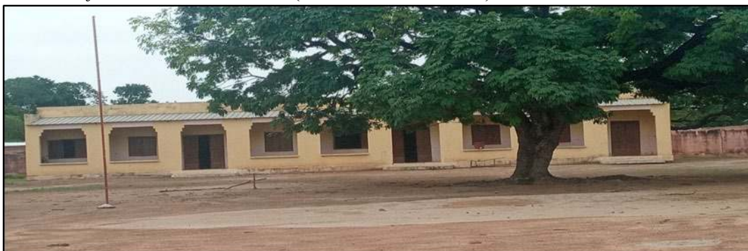
Photo 3 : école fondamentale construite par la mine d'or de Morila dans le village de Morila
